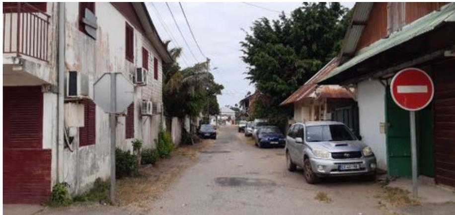
*Rue saint Joseph d'une largeur de 8m avec sa bande de roulement centrale en enrobé et ses accotements en terre sableuse*
