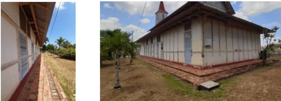
(2) Exemple de cunettes périphériques à l'aplomb des rives de toitures permettant de canaliser les eaux de pluies- Eglise de Sinamary
