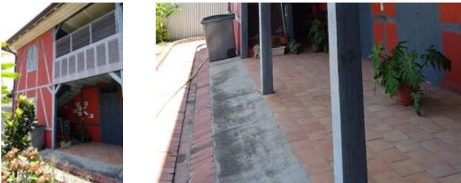
(1) Exemple de rigole d'écoulement ou cunettes permettant de canaliser les eaux de pluies- Jardins des Sœurs.
